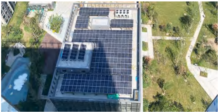
北京市北七家375KW居民楼顶
